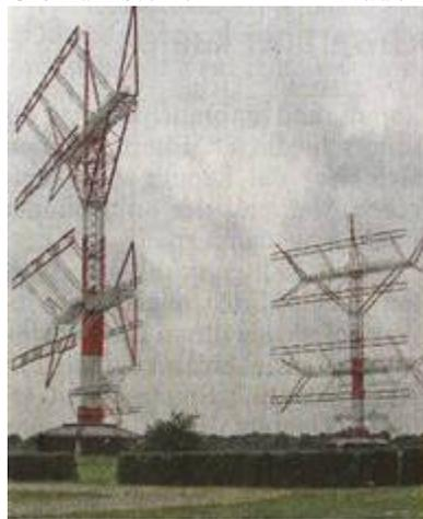
Die Telekom sanierte die Großfunkstelle Nauen: Es wurden vier neue Drehstandantennen von jeweils 80 Metern Höhe errichtet.
